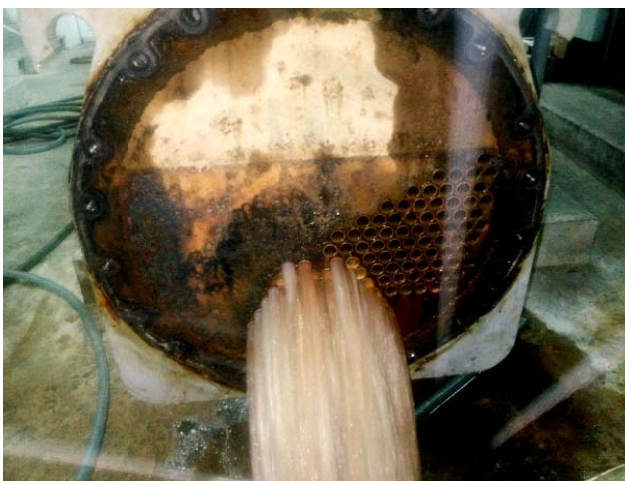
ทำการ Flushing ทำความสะอาดท่อ Condenser หลังแยงท่อเรียบร้อยแล้ว
