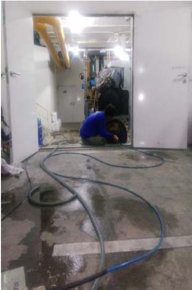
ทำการล้างทำความสะอาด ด้วยเครื่องSpin พร้อมแปรง Nylon Blush
